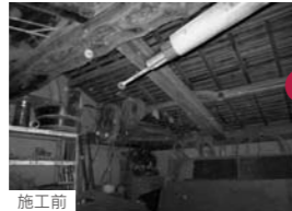
しっかりした骨組みの構造材、今回はその下で天井を造ると部屋の天井高さが確保できない！そこで、しっかりした構造材を磨き古民家風にみせることにしました。斜めの勾配天井の効果もあって高さを確保できました。
