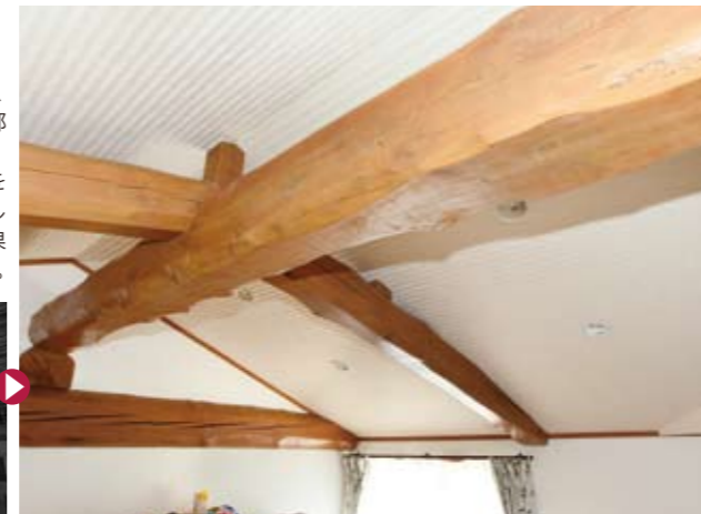
しっかりした骨組みの構造材、今回はその下で天井を造ると部屋の天井高さが確保できない！そこで、しっかりした構造材を磨き古民家風にみせることにしました。斜めの勾配天井の効果もあって高さを確保できました。
